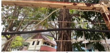
ภาพที่ 1 และ 2 การพันสายไฟ 220 V เอาไว้กับรั้วเหล็กด้วย Cable tie หรือบางบริเวณใช้ลวดผู่อำไว้กับแนวรั้ว พักที่สถานจอดรถของหอภาพยนตร์ ติดกับฝั่งรั้วของวิทยาลัยนาฏศิลป์ เห็นสมควรว่าควรติดตั้งใหม่ มีการร้อยท่อสายไฟให้ถูกต้องตามหลักวิศวกรรมไฟฟ้า
