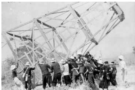
การตั้งหอสูงด้วยแรงคนสำหรับถ่ายมุมสูง แพร์
